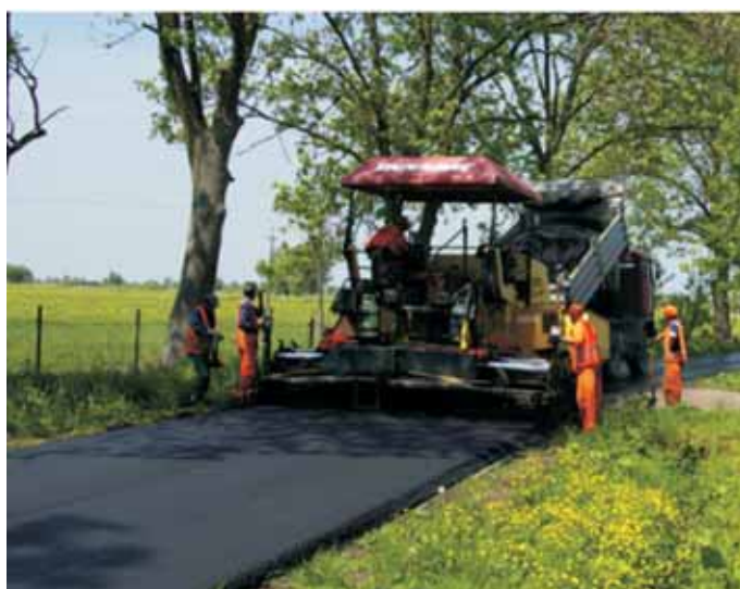
Przebudowa drogi gminnej w m. Drużno-Karczowizna- Dłużyna-Klepa.
