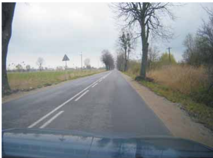
Wyremontowana droga Nr 1108 N w m. Bielnik Pierwszy. (wspólnie z samorządem powiatowym)
