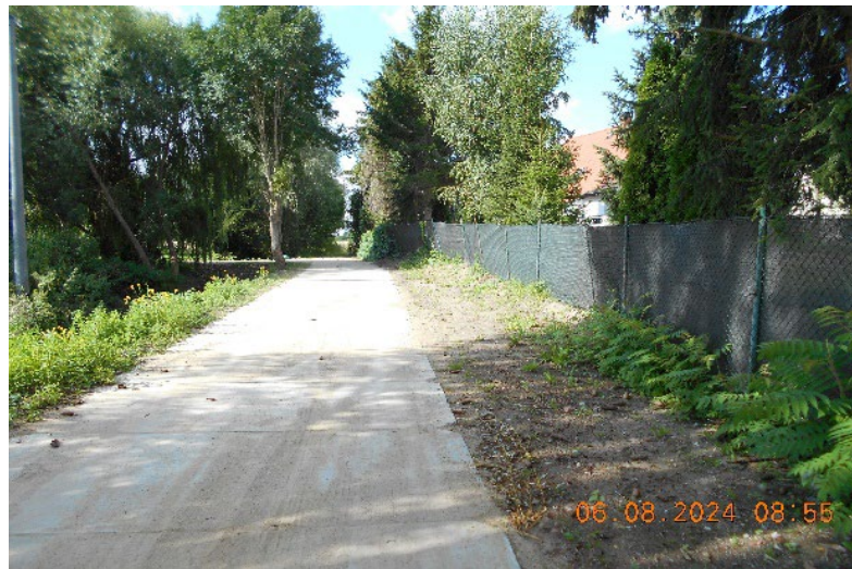
Remont nawierzchni odcinka drogi gminnej o dł. ok. 80 mb w m. Janowo. Koszt zadania: 83.480 zł. (Ułożenie płyt)
