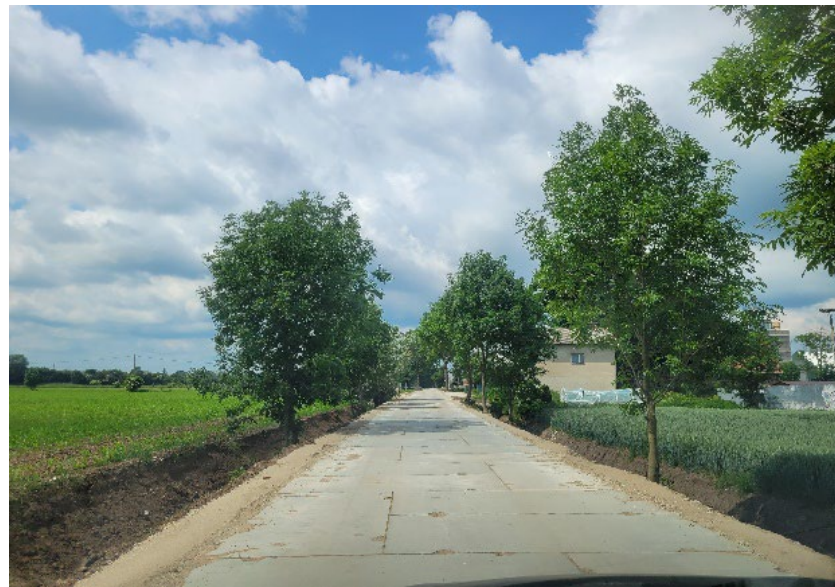
Remont nawierzchni odcinka drogi gminnej nr 101030N o dł. ok. 1 km w m. Adamowo. Koszt zadania: 1.442.723 zł. (Ułożenie płyt)
