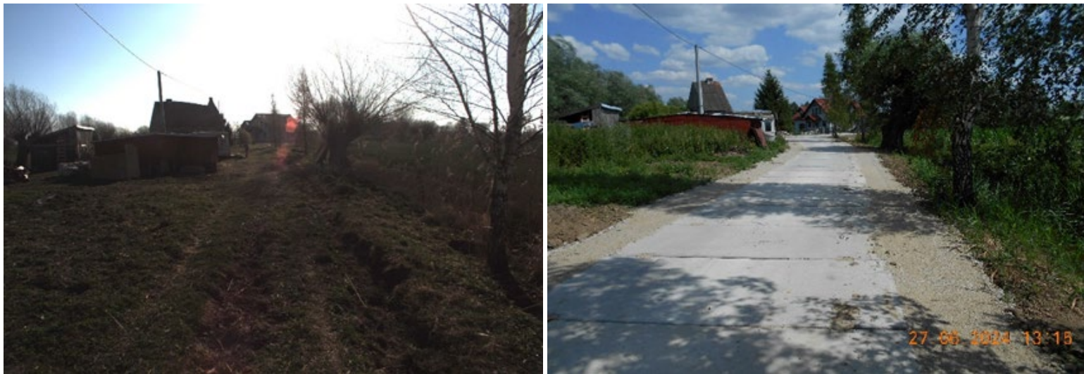
Remont nawierzchni odcinka drogi gminnej o dł. ok. 260 mb w m. Kępiny Wielkie. Koszt zadania: 343.500 zł. (Ułożenie płyt)
