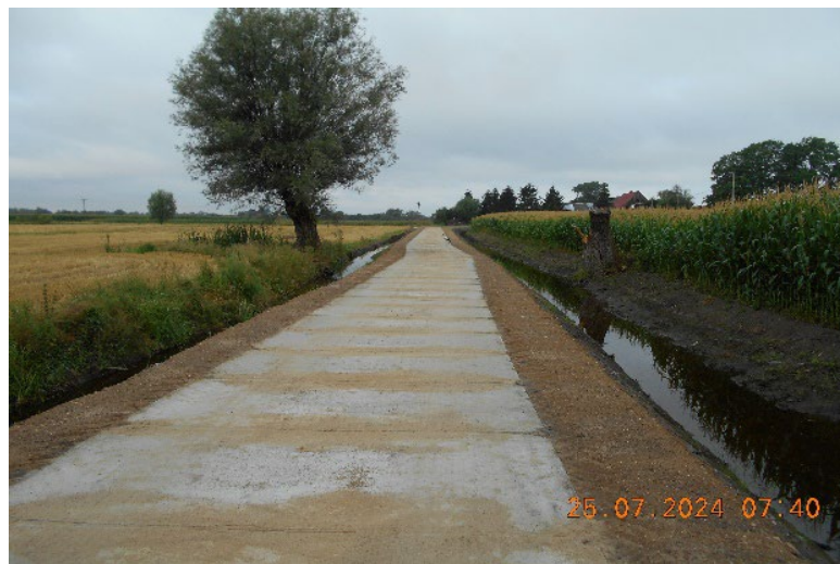
Remont nawierzchni odcinka drogi gminnej o dł. ok. 160 mb w m. Raczki Elbląskie. Koszt zadania: 163.591 zł. (Ułożenie płyt)
