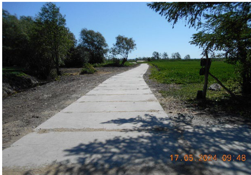
Remont nawierzchni odcinka drogi gminnej o dł. ok. 220 mb w m. Kępiny Wielkie. Koszt zadania: 191.746 zł. (Ułożenie płyt)
