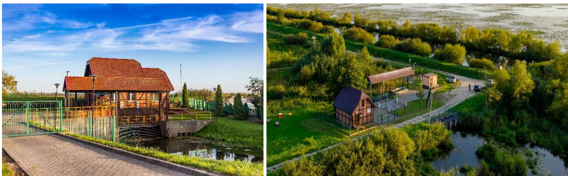
Stacja pomp Dłużyna i Nowotki
